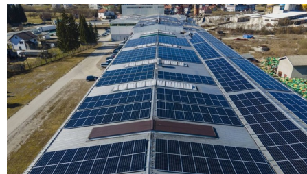
Solární elektrárna o výkonu 437 kW v podnikatelském areálu ESOF instalovaná v roce 2021 (Zdroj: radiodonjivakuf)
